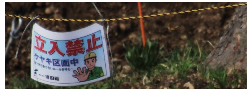
(上) 溝が掘られ、基礎工事が進む入間小跡地(4月20日撮影)。(下) ケヤキの根回りを保護する現場掲示
